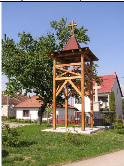
Rekonštrukcia drevenej zvonice – nové stavebno-technické prevedenie
