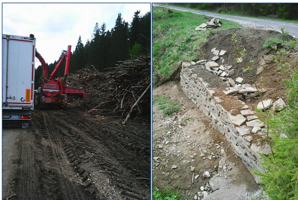
Obrázok 12 Výroba drevnej štiepky v lesoch Obce Ľubica (vľavo), práce na lesných komunikáciách, spevňovanie krajnice - lesy obce Ľubica (vpravo)
